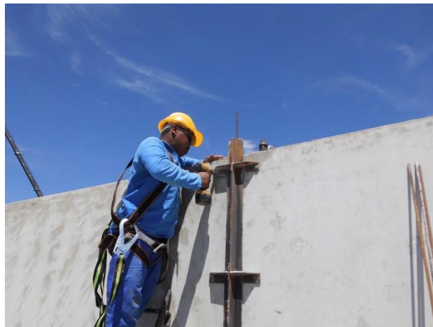
Figura 22 – Fixação do perfil metálico ao painel
