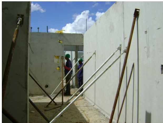
Figura 20 – Escoramento do painel
