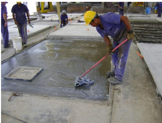
Figura 11 – Aplicação de desmoldante na pista de concretagem
