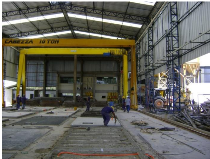
Figura 1 – Vista geral da produção dos painéis na fábrica de Várzea Paulista
