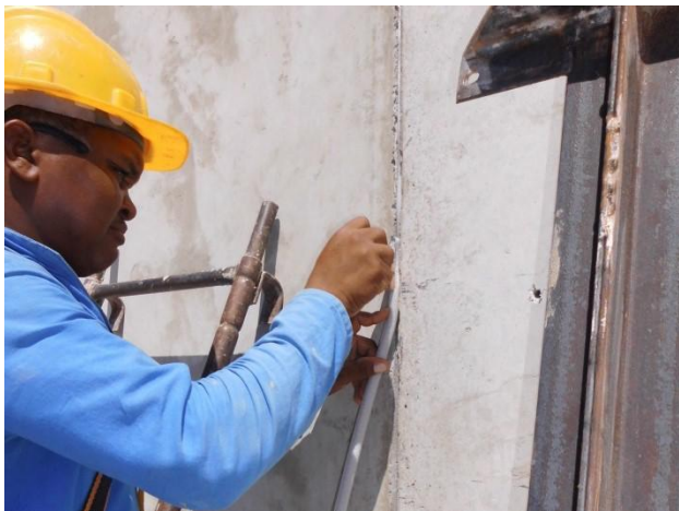
Figura 21 – Colocação do delimitador de fundo de junta
