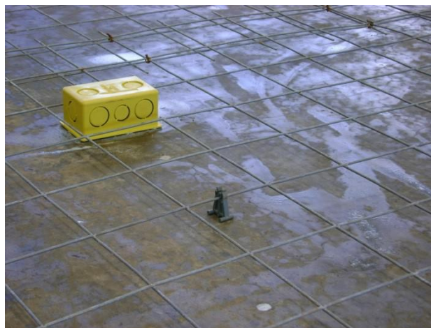
Figura 12 – Utilização de espaçador para posicionamento da tela
