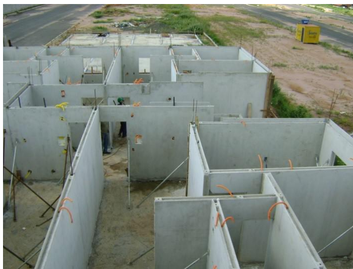
Figura 10 – Vista geral da montagem dos painéis na obra
