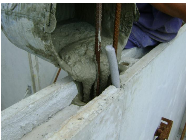
Figura 21 – Colocação do delimitador de fundo de junta
