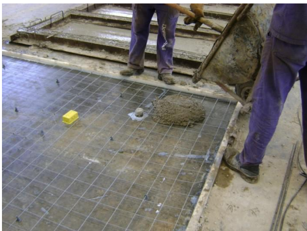
Figura 13 – Concretagem da face do painel
