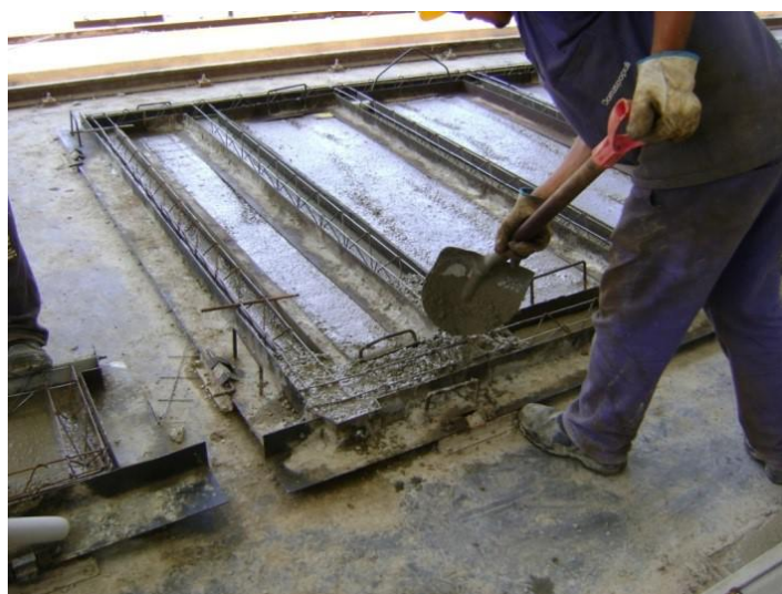
Figura 15 – Concretagem das nervuras e do quadro externo da primeira placa
