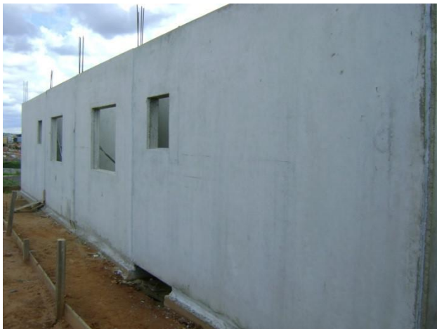
Figura 19 – Posicionamento do painel sobre baldrame
